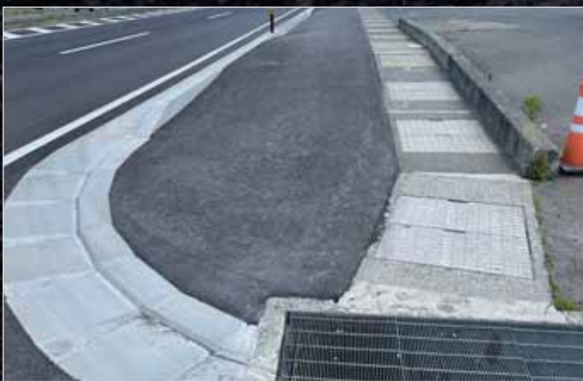
歩車道境界ブロック・既設側溝 舗装後
