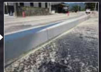
④ 施工完了
