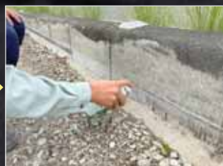
プライマー塗布 (既設躯体の場合)
