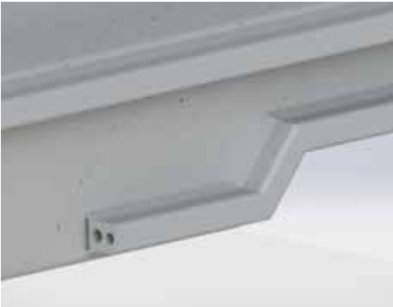
設置状況②
