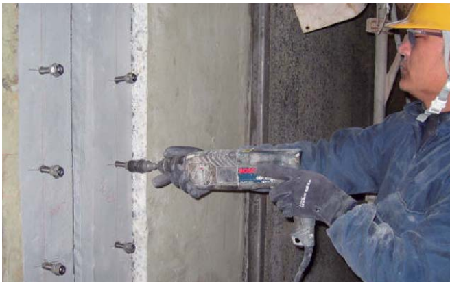
アンカー打ち込み状況
