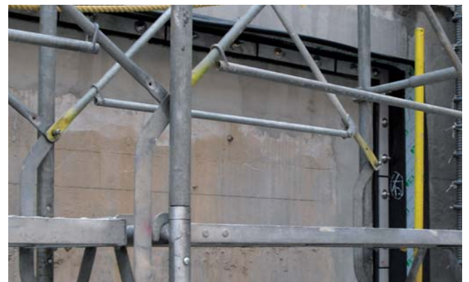
仕上がり状況
