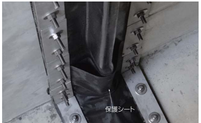
保護シート取付状況
