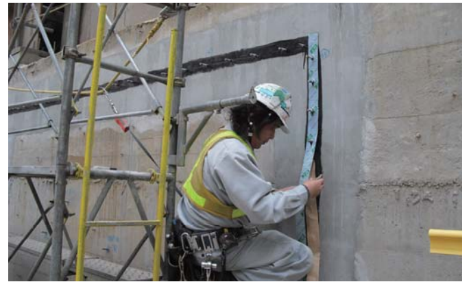
シール材貼付け状況
