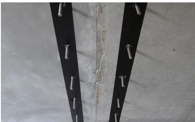
サンタックボンドPB-50塗布状況
