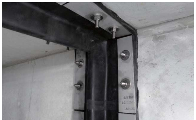
仕上がり状況
