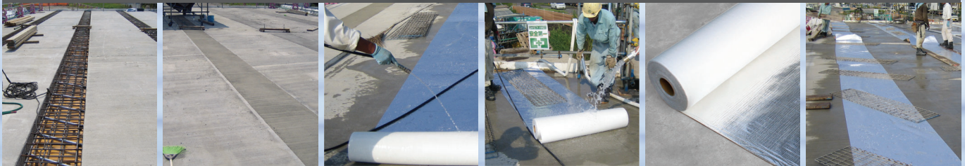
コンクリート打設前
